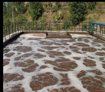
特点：热轧废水含有大量氧化铁和油，水温高、水量大。
