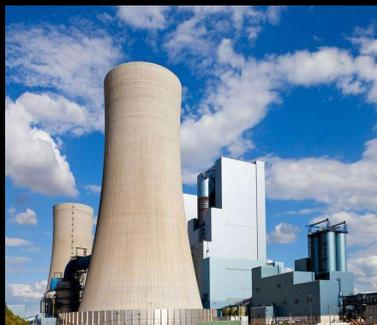
特点：排水量非常大占全场排污的60%-80%。水质特点氯离子、硬度较高，水中含有残留化学药剂容易产生二次污染，无法二次利用。
